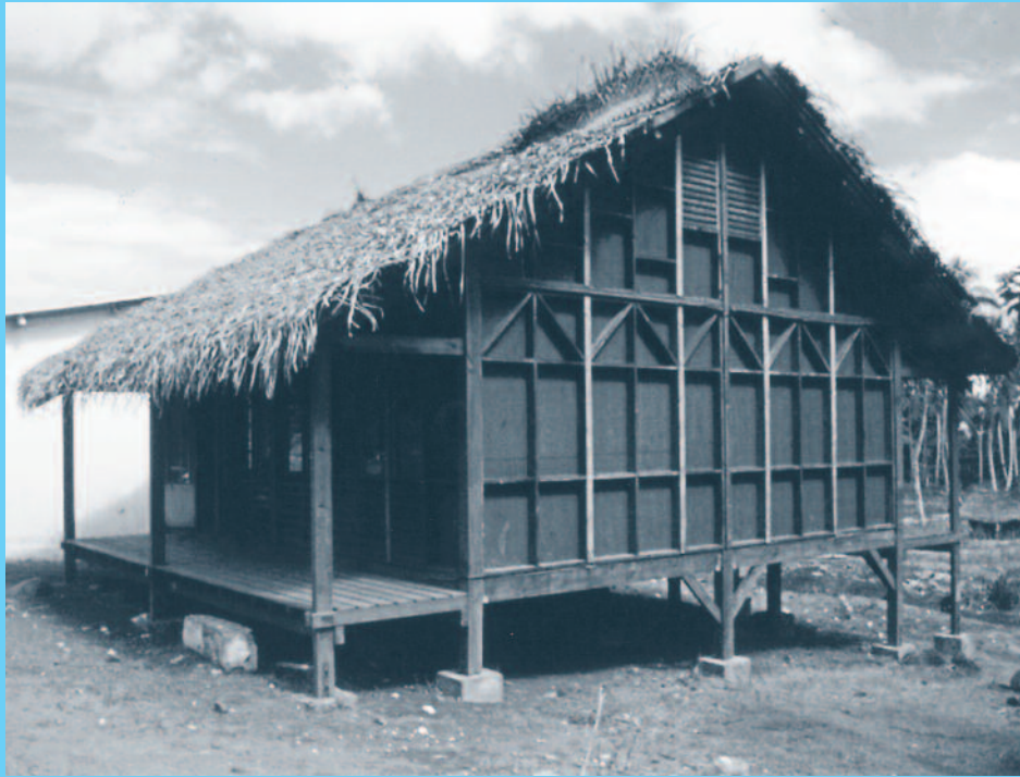
Chirongui, salle de classe de type Kamiclass 27 , 1985 Réalisation : Direction de l'Équipement.
