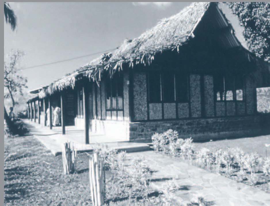
Mamoudzou, bâtiment de la Dasu Réalisation : Atelier mahorais d'architecture.
